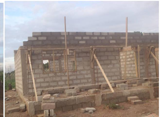
Mit dem Aufmauern waren wir am 6. Juni 2014 fertig. Anschließend folgte eine kurze Pause, denn wir mussten auf das Holz für den Dachstuhl warten. Das Holz bestellten wir ebenfalls bei uns im Dorf. Die geeigneten Bäume mussten zuvor noch gefällt und zugeschnitten werden. In dieser Zeit konnten wir nicht wirklich etwas machen, außer immer wieder beim Landwirtschaftsprojekt die Felder zu beobachten und Unkraut zu jäten.
